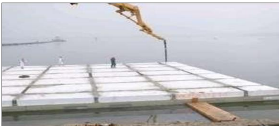
Gambar 1. Pemanfaatan bahan styrofoam sebagai pondasi rumah apung
