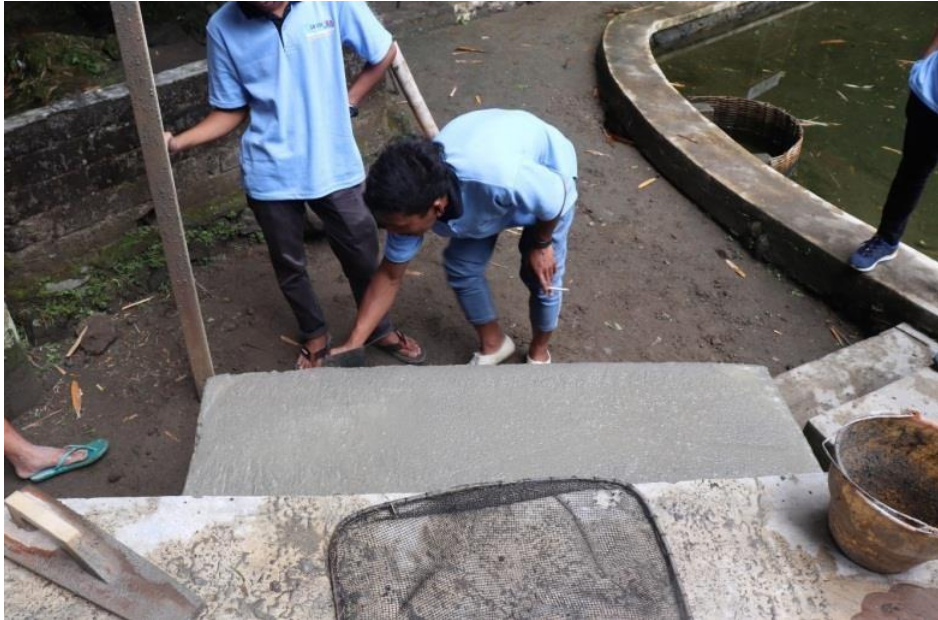
Gambar 1: Pemasangan fasilitas umum berupa kursi taman
