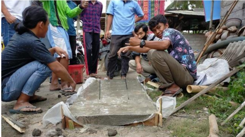
Gambar 4: Pembuatan kursi taman dengan metode cor beton
