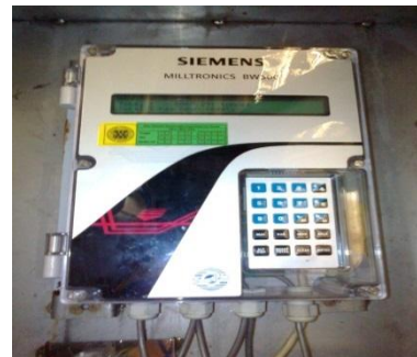
Gambar 12. Alat pembaca kecepatan belt conveyor
