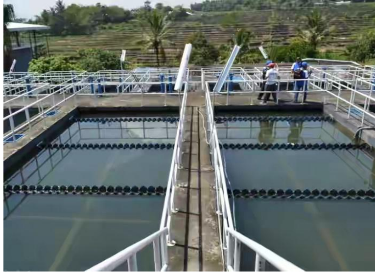
Gambar 4. Proses Pengendapan Air (Sedimentasi)
