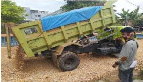
**Gambar 8.** Pengangkutan Material Agregat Kelas B
