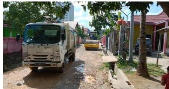
**Gambar 11.** Penyiraman Material Agregat Kelas B
