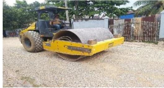
**Gambar 10.** Pemadatan Material Agregat Kelas B
