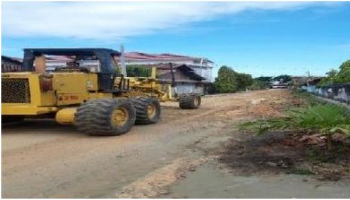
**Gambar 7.** Proses Penyiapan Badan Jalan
