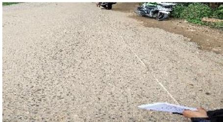
**Gambar 16.** Pengausan Agregat
