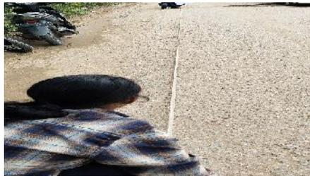
**Gambar 17.** Pengausan Agregat
