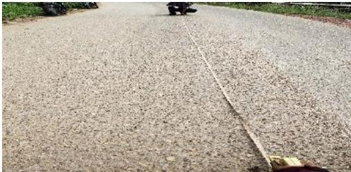
**Gambar 26.** Pengausan Agregat
