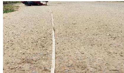
**Gambar 22.** Pengausan Agregat
