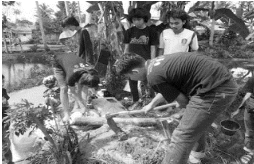
Gambar 5. Penggalian tiang solar panel
