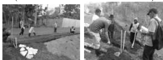
Gambar 11 Pengukuran Kontur Tanah dan Pemasangan Bowplank di Sisi Timur Lahan (Sumber: Tim Desain PKM FT. UTP)
