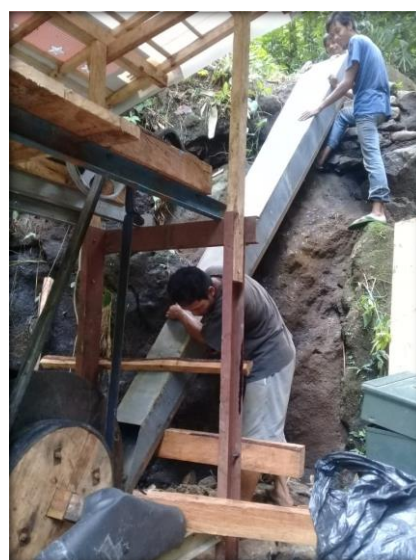
Gambar 14. Instalasi penstock
