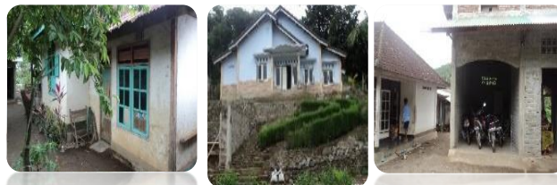
Gambar 1. Bentuk Bangunan Saat ini di Wilayah Wet Bebekeq dan Pamaru
