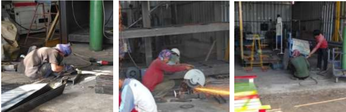
Gambar 1. Kondisi pekerja saat melakukan pekerjaan
