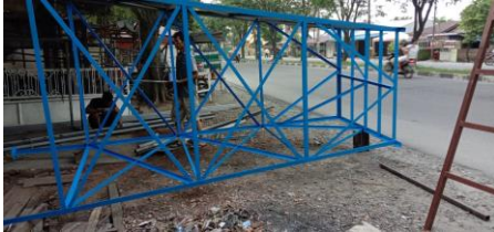
Gambar 2. (Proses instalasi pompa sumur dalam di Desa Pekan Sawah)
