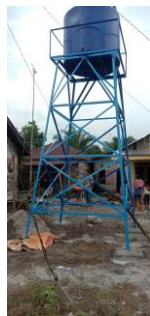
Gambar 3. (Pompa sumur dalam di Desa Pekan Sawah sebelum Uji Coba)
