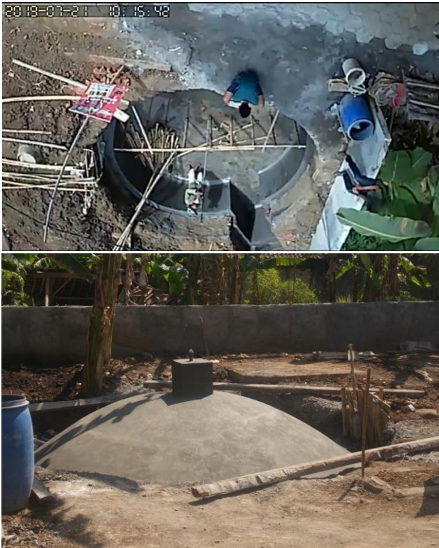
Gambar 5. Pembangunan dan pembuatan Biodigester
