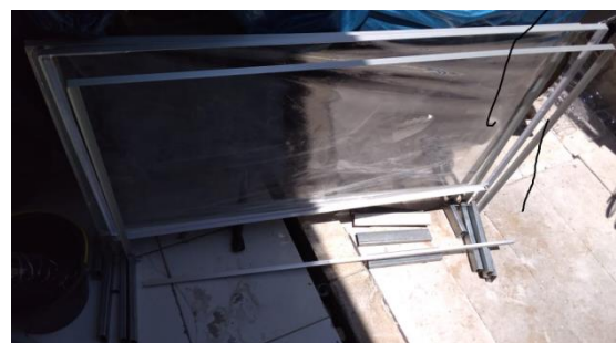
Gambar 6. Pemasangan plastik tebal
