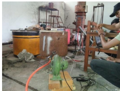
Gambar 2.5 Instalasi burner dan pengujian
