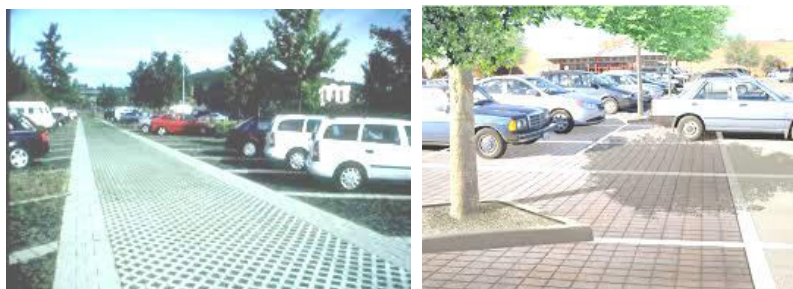
Gambar 4 Penggunaan Paving Grass dan Paving Block sebagai perkerasan parkir
