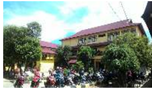
Gambar 3. Kontruksi bangunan Fakultas Teknik Komputer
