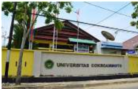
Gambar 2. Kontruksi bangunan Universitas Cokroaminoto Palopo
