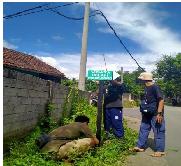
Gambar 4. Pemasangan Papan Penunjuk Arah Menuju Kolam Manggong
