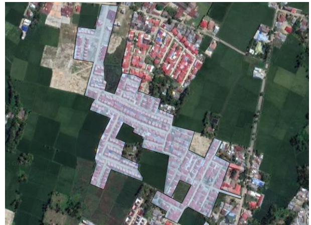
Gambar 3. Batas Perumahan Griya Dulomo Indah
