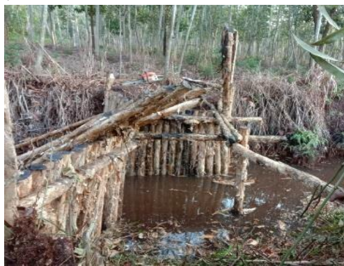
Gambar 2. Proses Pembuatan Sekat Kanal
