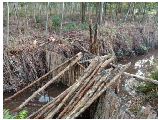
Gambar 2. Proses Pembuatan Sekat Kanal
