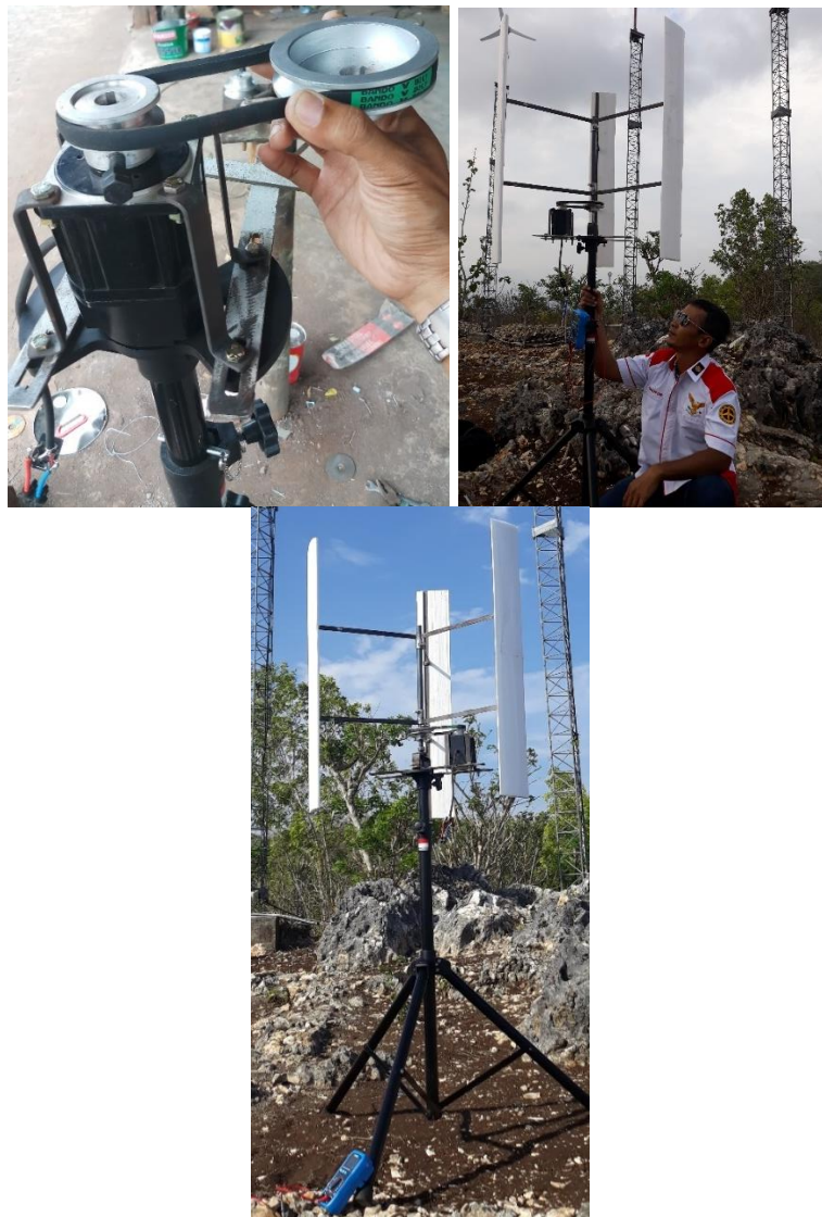
Gambar 11 Proses pembuatan konfigurasi three straight blade vertical axis wind turbin GR1
