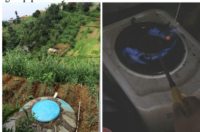
Gambar 5. Pasca Instalasi Digester (kiri) dan Nyala Api Biogas yang Dihasilkan (kanan)
