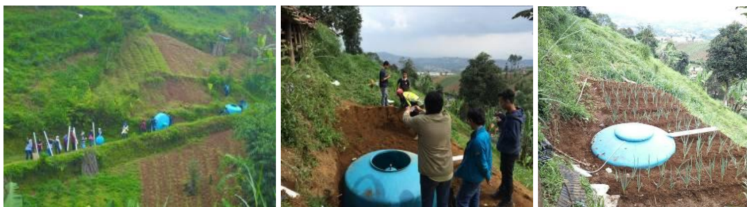
Gambar 4. Proses instalasi digester biogas dan penanaman digester
