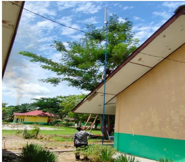
**Gambar 6.** Antena Omni sudah terpasang
