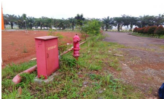
Gambar 2. Instalasi sistem pipa hydrant pada Gedung Simulator STPI. (Sumber : Hasil Dokumentasi,2017)
