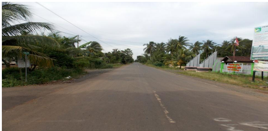
Gambar 3. Keadaan Jalan Menuju Bukit Birah
