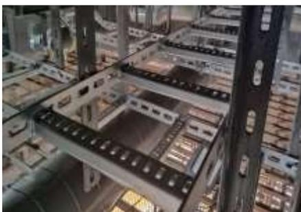
Gambar 6.5. hasil akhir Instalasi *cable ladder*
