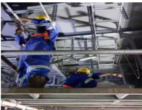
Gambar 6.1. Pemasangan HDG cable ladder
