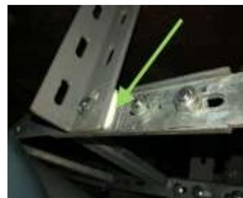
Gambar 6.2. Pemasangan Teflon
