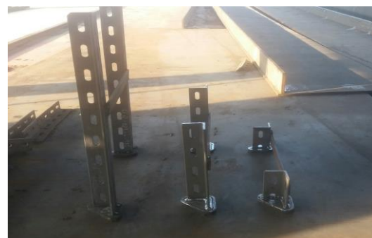
Gambar 3.7 doubler plate yang sudah terpasang di support
