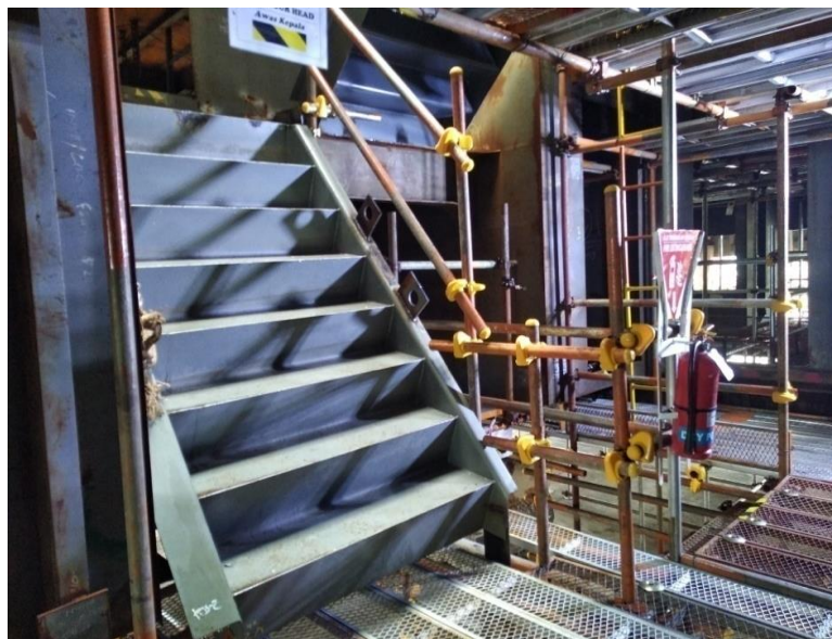
Gambar 3.6 Pemasangan Outfitting (internal Stairway) Pada Tahapan Kapal Saat Erection After Assembly
