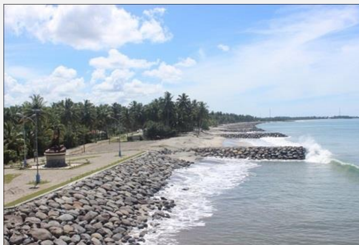
Gambar 3. Groin sebagai perlindungan garis Pantai di Sumatera Barat (Sumber: Prayitno, 2015 )
