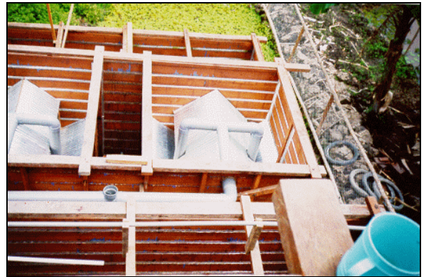
Gambar 6. Bak Flokulasi, koagulasi dan sedimentasi
