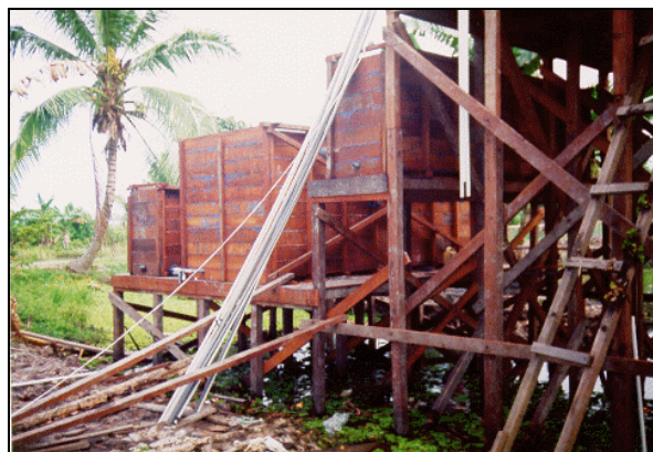
Gambar 7. Instalasi Pengolahan air gambut kontinyu
