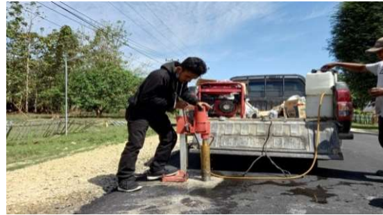
Gambar 6. Pengujian core drill AC-BC Sumber : Dokumentasi Lapangan (2020)
