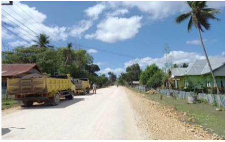
Gambar 3. Pengangkutan material AC-BC Sumber : Dokumentasi Lapangan (2020)
