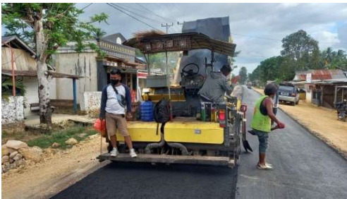
Gambar 4. Penghamparan material menggunakan Aspal finisher Sumber : Dokumentasi Lapangan (2020)
