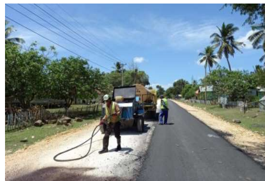
Gambar 2. Proses penyiraman Aspal perekat.
