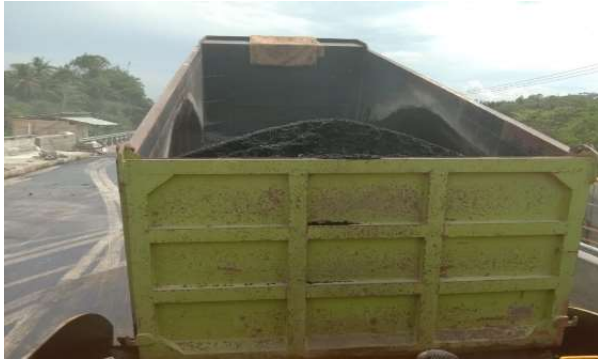
Gambar 3. Pengangkutan material AC-BC Sumber : Dokumentasi Lapangan, 2020
