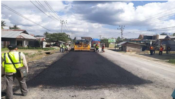
Gambar 4. Penghamparan material menggunakan Asphalt finisher Sumber : Dokumentasi Lapangan, 2020
