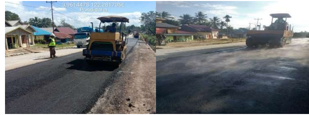
Gambar 5. Pematatan material AC-BC Sumber : Dokumentasi Lapangan, 2020
