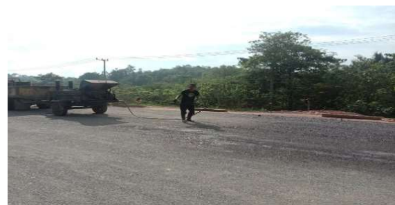
Gambar 2. Proses penyiraman Aspal perekat.
