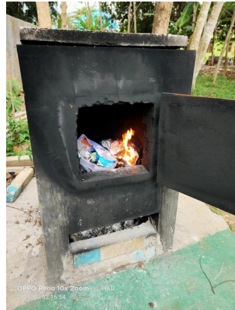
Gambar 2. Tungku pembakaran sampah yang sudah dibuat dan digunakan
