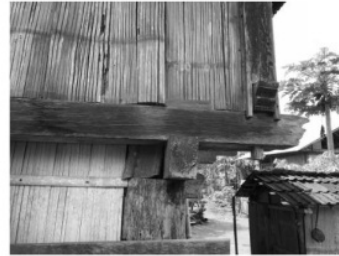
Gambar 10. Sambungan kolom dan balok tidak menerus
