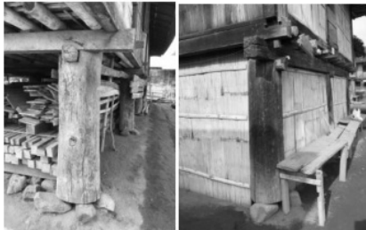
Gambar 8. Detail sambungan umpak dengan tanah
