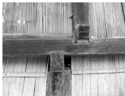
Gambar 12. Detail sambungan kolom dan balok tidak menerus
