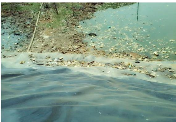
Gambar 9. Lapisan Geotekstil di Penampungan Lindi
