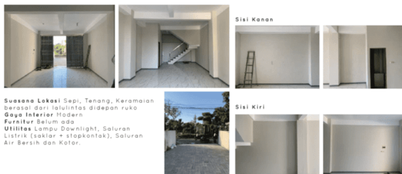
Gambar 6. Interior kondisi Existing pada Bangunan Ruko Pandugo (Sumber: Dokumentasi Penulis, 2021)
