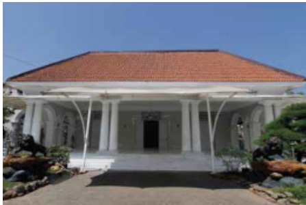
Gambar 2.5. Gedung Wolu (Sumber: Yulis, 2018)
