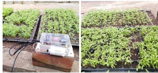
Gambar 10. Pemasangan source node di dalam greenhouse
