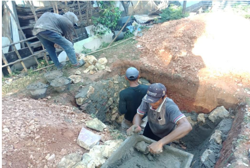
Gambar 2. Pembuatan Septik Tank Komunal
