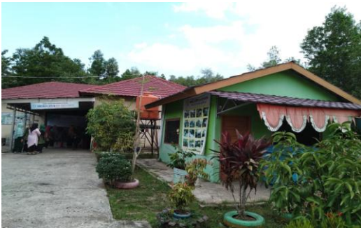
Gambar 1. Lokasi TPS 3 –R dan Bank Sampah Sakura.
