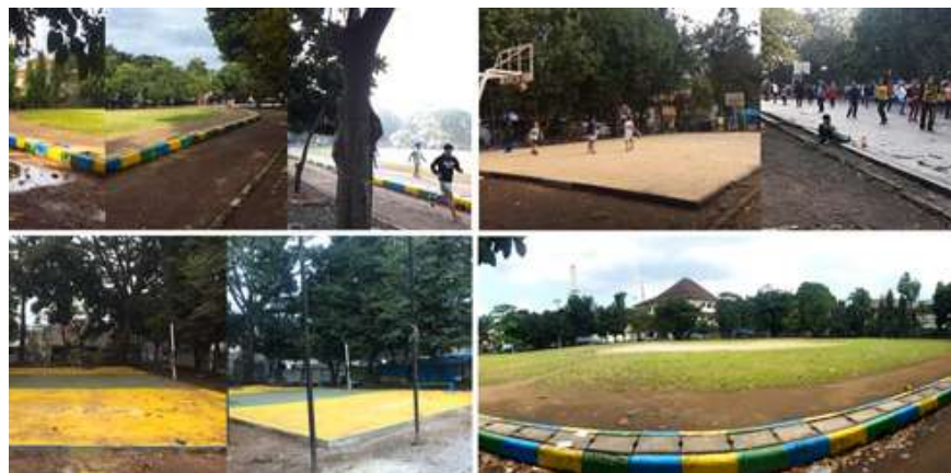
Gambar 3. Kondisi eksisting area olah raga ( sport area ) lapangan Gasmin (sumber: Sri Soedewi, 2020)
