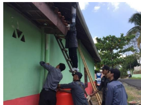
Gambar 6. Pemasangan Alat Panen Hujan (Sumber :Dokumentasi Pribadi)
