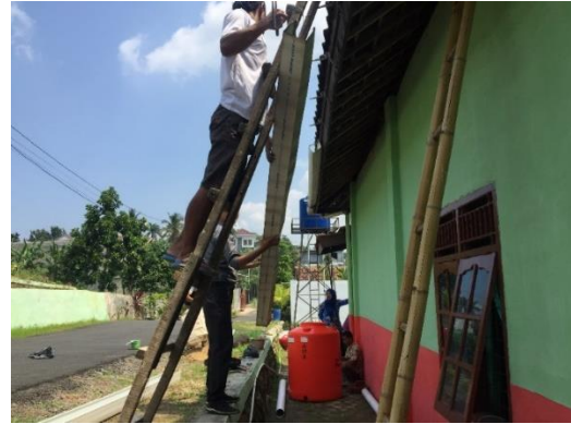
Gambar 4. Penggantuan Talang Air (Sumber :Dokumentasi Pribadi)
