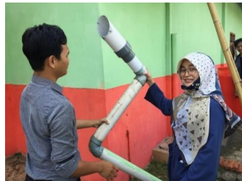
Gambar 5. Perakitan Alat Panen Hujan (Sumber :Dokumentasi Pribadi)
