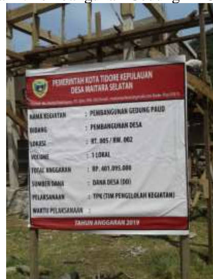
Gambar 1. Pembangunan Gedung PAUD
