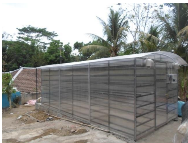
Gambar 5. Implementasi exhaust fan dan sistem elektronik pada bangunan pengering
