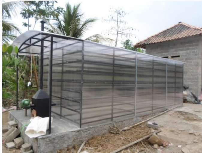
Gambar 6. Implementasi tungku biomassa pada bangunan pengering
