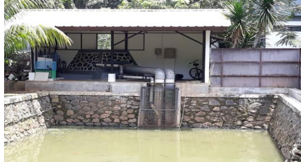
Gambar 7. Kondisi Real Kolam Penampungan Air Pusdiklat Bea & Cukai
