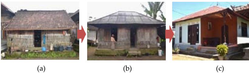
Gambar 8 Dimensi bangunan tinggal Bali Aga awal (a) dengan proporsi bukaan lebih kecil jika dibandingkan pada bangunan tinggal Bali Aga pada periode-periode berikutnya (b-c)
