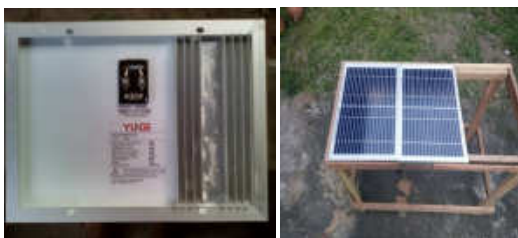
Gambar 2. Kondisi Pemasangan Perangkat Dan Modul Surya.
