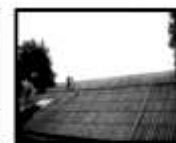
Gambar 11 Bambu balok sebagai penutup atap Sumber : Yayasan Lembaga Bambu Indonesia, Lembang
