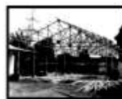
Gambar 9 Kuda-kuda Bambu dengan Bentang 12 m Sumber : www.google.com
