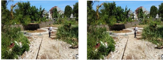
Gambar 19. Pembangunan jalan setapak
