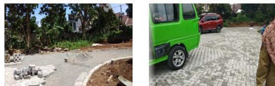
Gambar 18. Pembangunan lahan parkir
