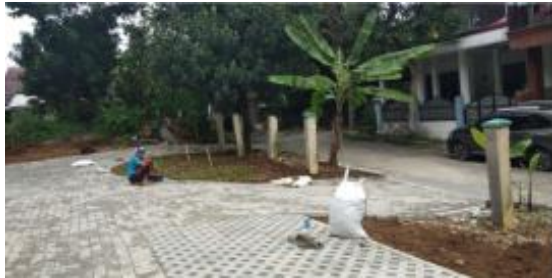
Gambar 20. Perbaikan pagar taman lingkungan
