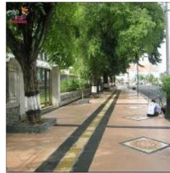
Gambar 8: situasi Trotoar sisi Kanan
